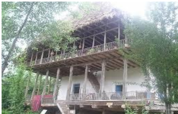
FIGURE 15 استفاده از چوب در خانه های روستایی
