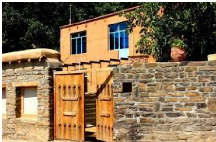
FIGURE 13 استفاده از سنگ و کاه گل به عنوان مصالح اصلی خانه روستایی
