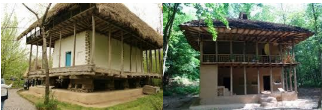
FIGURE 3 ساخت خانه های روستایی در ارتفاع و فاصله از زمین در شمال کشور و سازگاری با طبیعت و اقلیم
