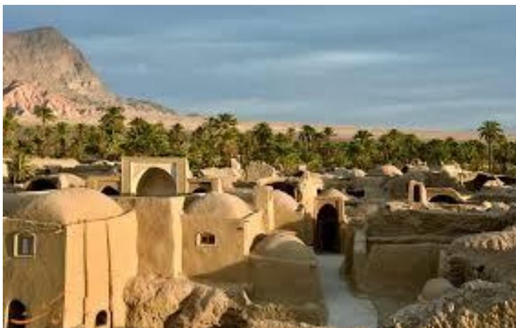
FIGURE 14 استفاده از خاک و کاه گل موجود در طبیعت و بام های گنبدی در خانه های روستایی
